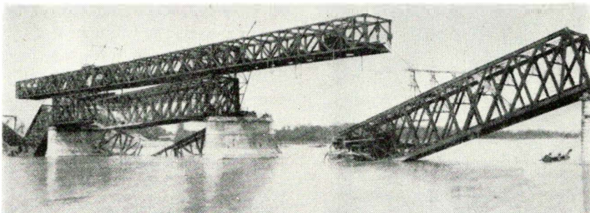
Genopbygning af Tullner-broen over Donau.
